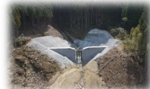
<砂防ダムの設置>
