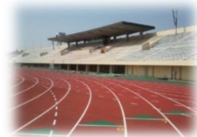
<久留米スポーツセンター 陸上競技場>
